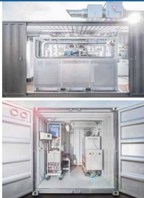
Dampf-Elektrolyse (oben) Off-Grid-Power Generator (unten)
